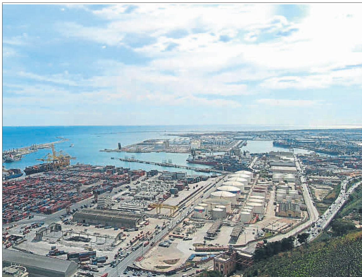
La zona de actividades logísticas (ZAL) del puerto de Barcelona
